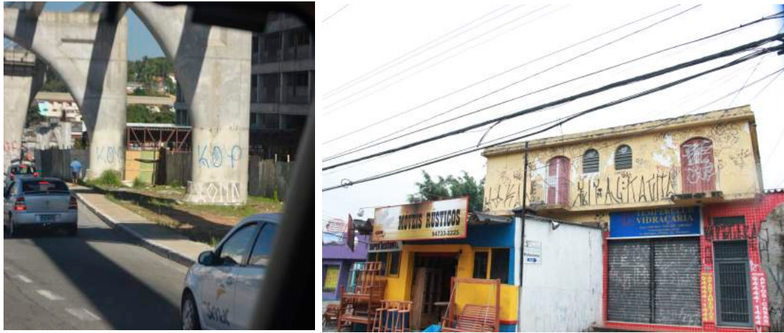
Figuras 29 e 30: Estruturas viárias de concreto ocupadas por pixos e pontos comerciais que presentificam valores distintos dos encontrados nas centralidades. Imagens de registro do grupo, junho/2017.
