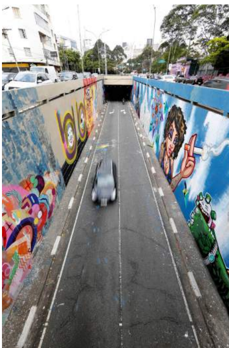
Figura 26: Grafites ocupam toda a extensão da saída do Túnel Noite Ilustrada, uma das ligações entre Avenida Rebouças, Paulista e Doutor Arnaldo. Foto de André Porto/Metro Jornal.
